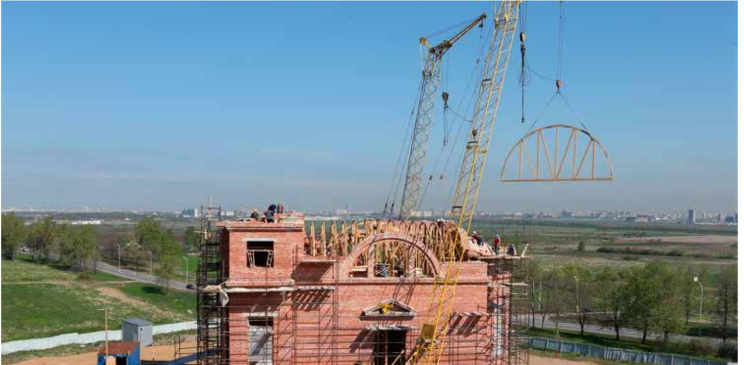
Installazione di centine per la muratura in mattoni delle volte
